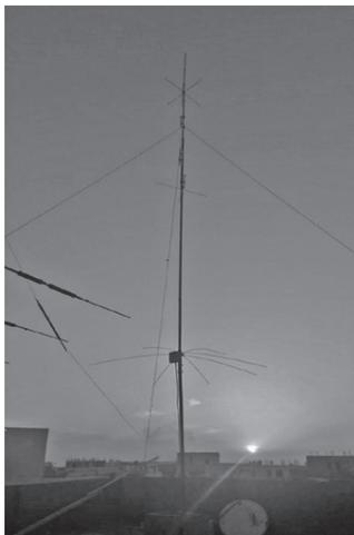
SU1SKのR7パチカル・アンテナ他に14/21/28MHz用八木宇田アンテナも使っている
